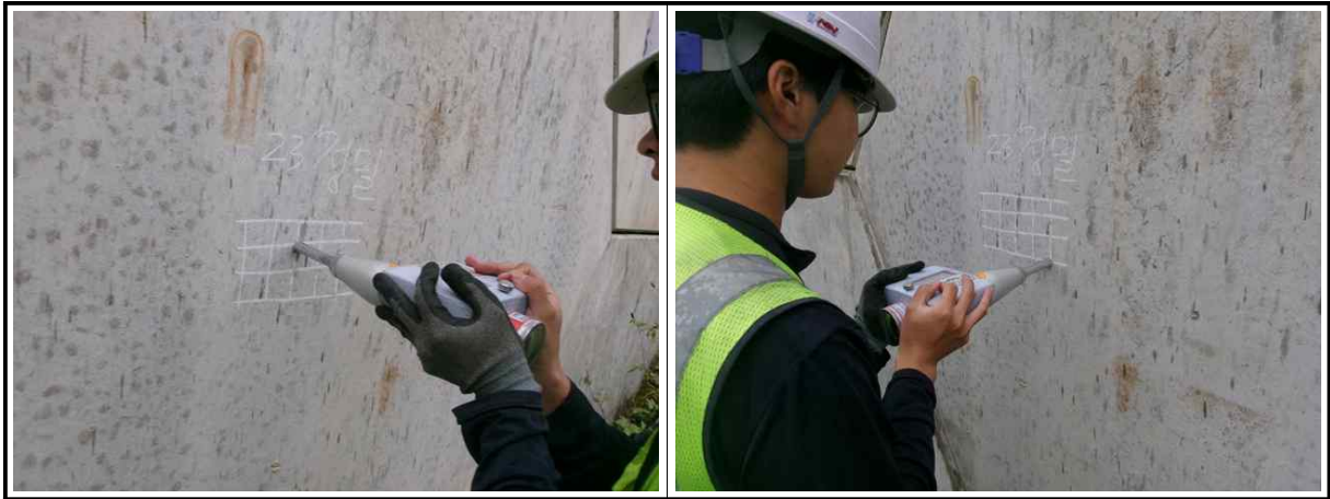
【그림 11.3.6】 슈미트해머를 이용한 반발경도시험 전경
